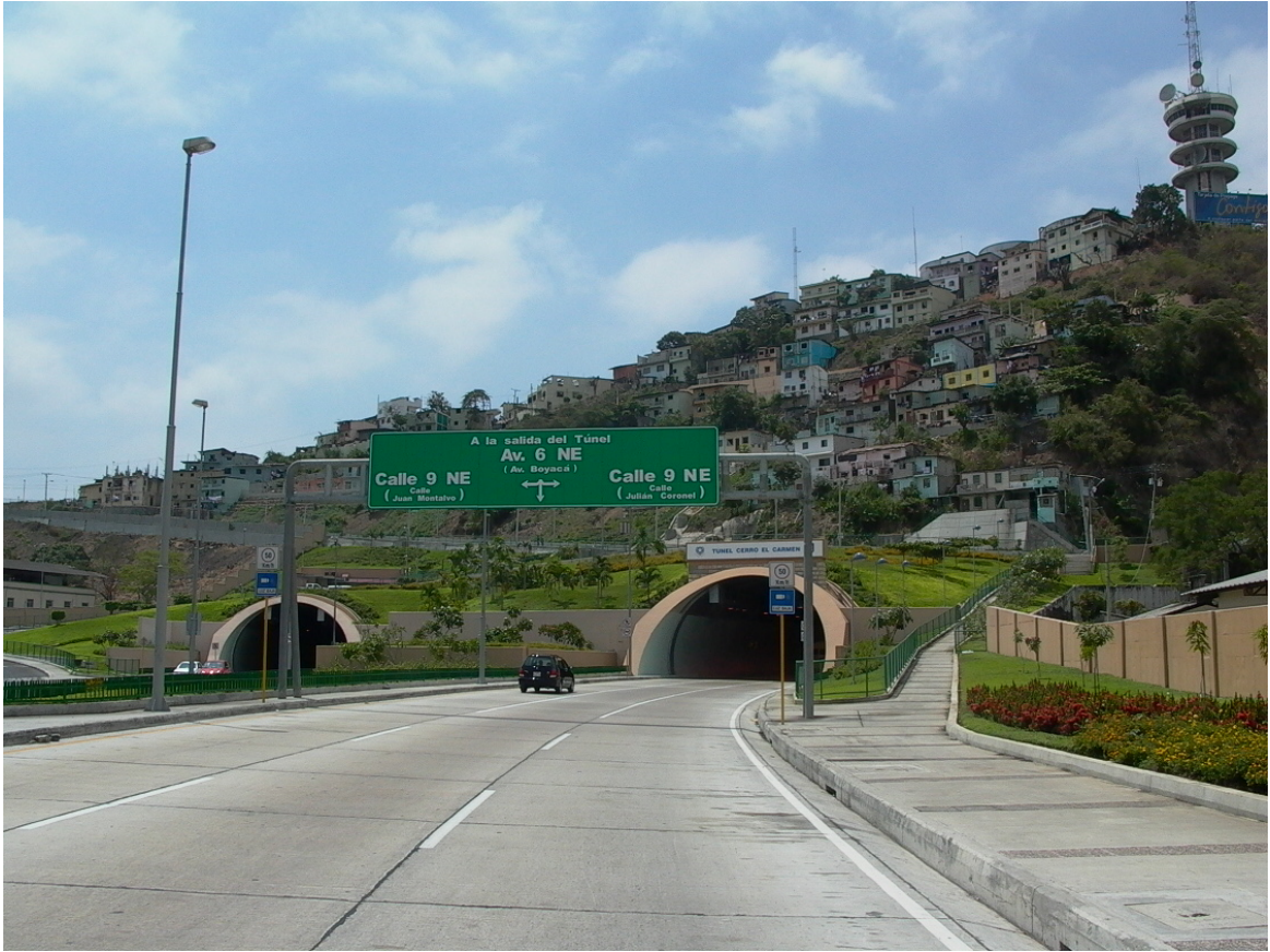
Túnel cerro El Carmen, Guayaquil (Ecuador)
