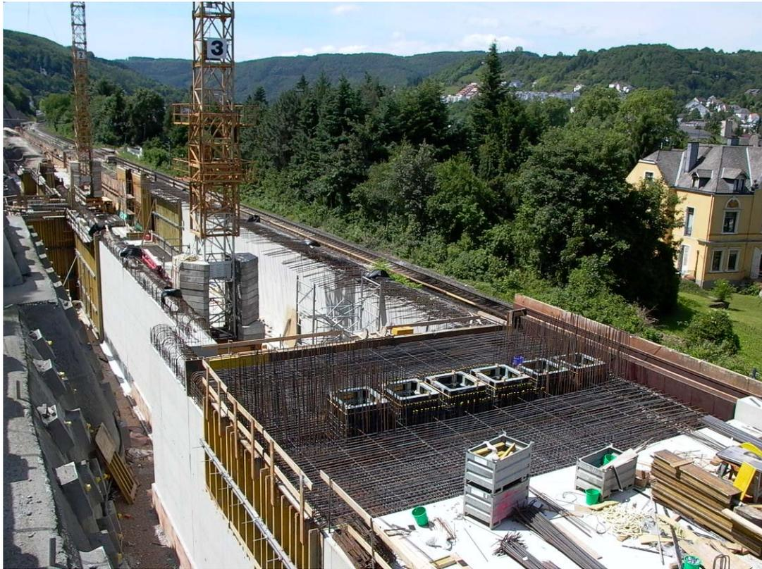
Las chimeneas para la extracción de humos de los ventiladores se instalarán preferiblemente en la cubierta del túnel y perpendicularmente al eje del túnel, a fin de eliminar todos los gases de humos e incendios del túnel. Para la ventilación del túnel y control de inmisión, se prevé un equipamiento separado (09 de Junio del 2003).
